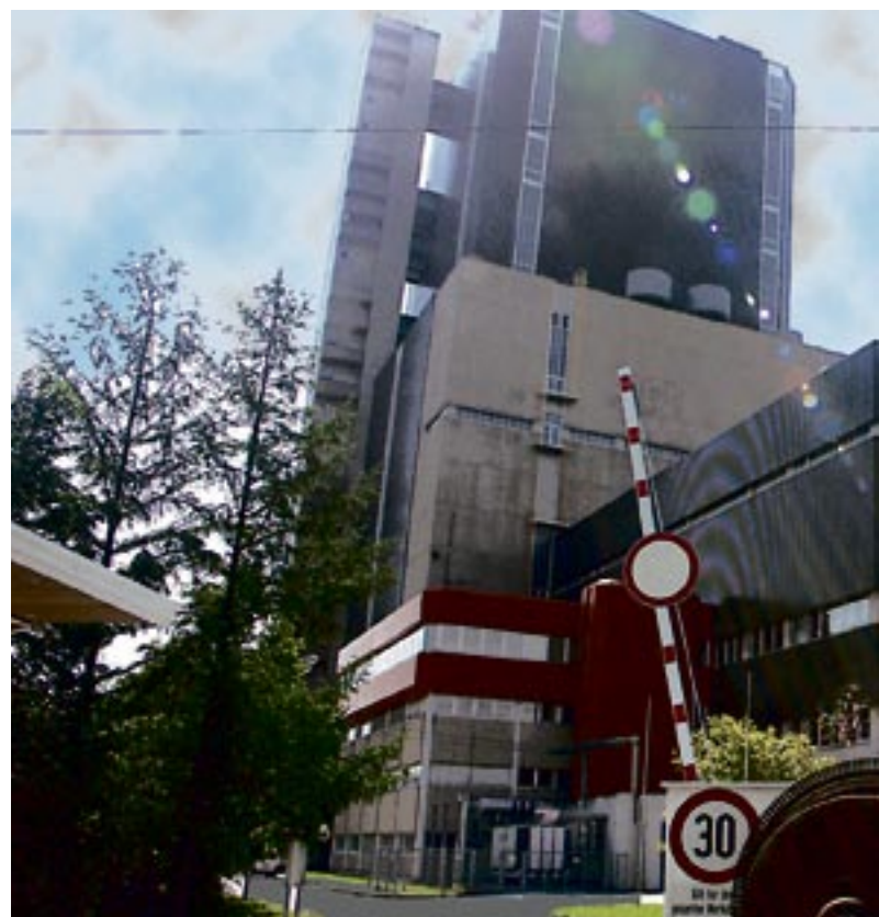
Anderes Brennmaterial, mehr Betriebsstunden: Das Kraftwerk Voitsberg III
