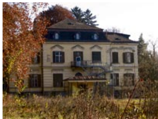
Die Villa Hartenau wird seit Jahren dem Verfall preisgegeben. Der Abriss droht.
