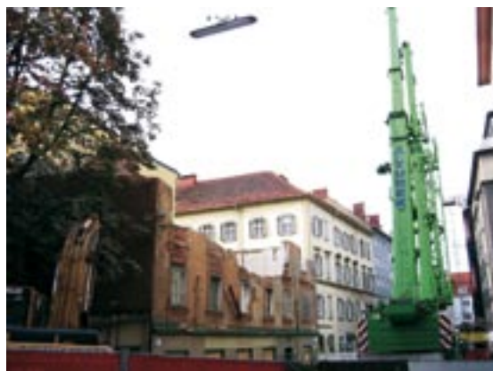
Das denkmalgeschützte Kommodhaus wurde im Kulturhauptstadtjahr 2003 geschliffen.
