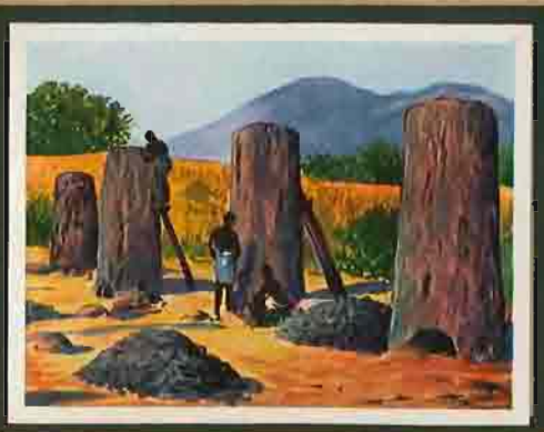
193 Einheimische Eisenschmelzen in Danjelli, Nordlogo. Die Ofen sind etwa 3 m hoch. Man gewinnt aus ihnen 30-35 kg schwere, nierenförmige Eisenstücke, die an die umwohnenden Negerstämme verkauft werden. Diese fertigen daraus Werkzeuge und Waffen.
