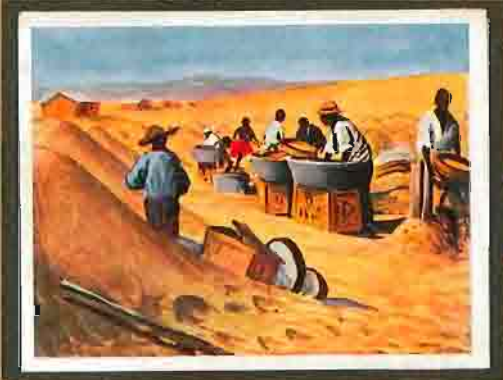
143 Diamantengewinnung bei der Kolmanuskubbe (Südlich von Lüderitzbucht). Der durch Sieben von Feinsand befreite Kies wird teilweise noch mit der Sand in Sieben gewaschen und geflegt, und der Diamant dann ausgelesen.
