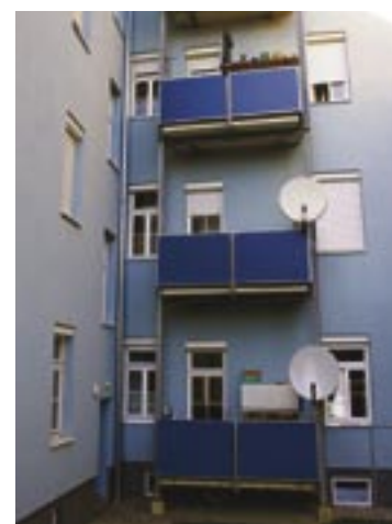
Hackergasse 32: Wohnanlage erbaut 1899, 19 Wohnungen, umfassend saniert 2004.
