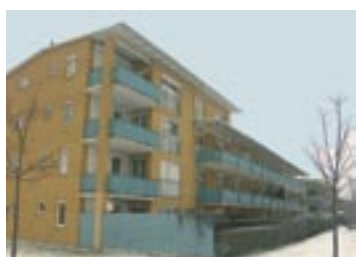
Wohnanlage Straßgang: 297 Wohnungen zwischen Scherer- und Burenstraße, erbaut 2004.
