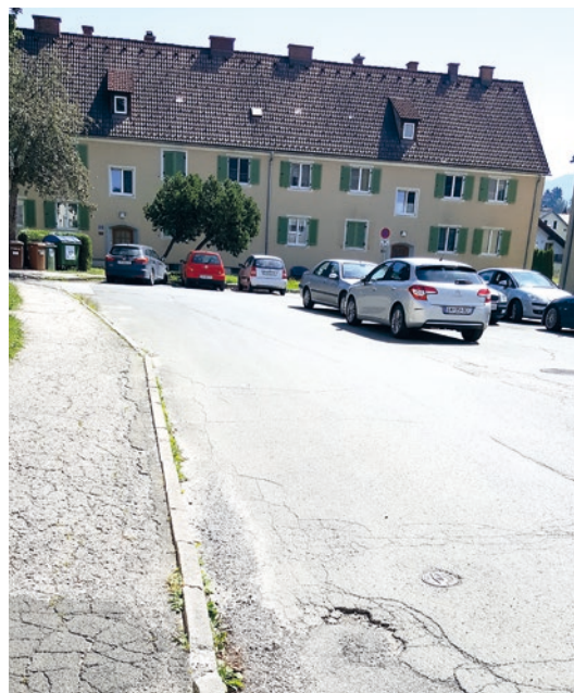
Die Lewaldstraße wird nun saniert
